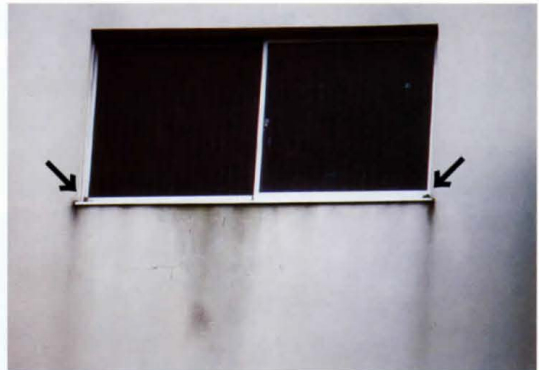
図-7 塔屋のサッシ窓枠の下方両隅に貯蔵された餌、左側がハクセキレイ、右側がスズメである。
